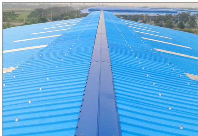
Công trình Nhà máy mạ luyện thép
