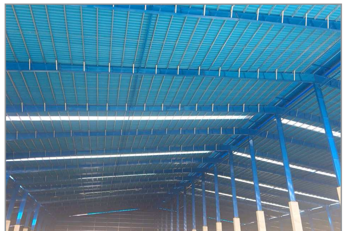
Công trình Nhà máy Phân bón
