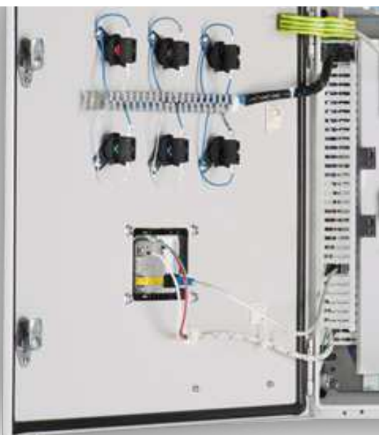
Tấm PVC dùng chế Electrical cabinets,
